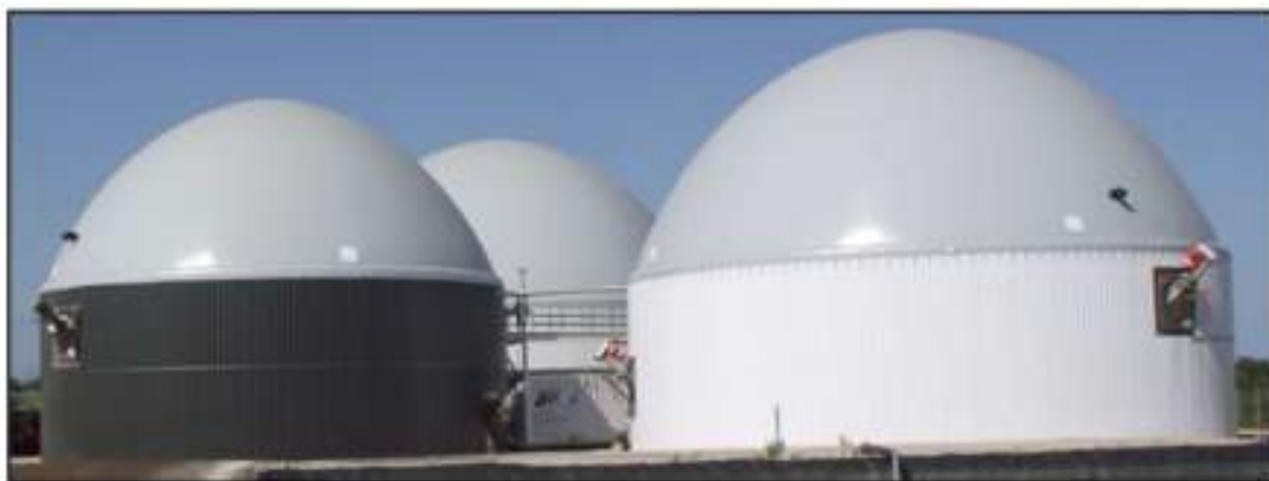
Ilustración 7. Ejemplo de reactores. Planta de biogás, tecnología AGF.
