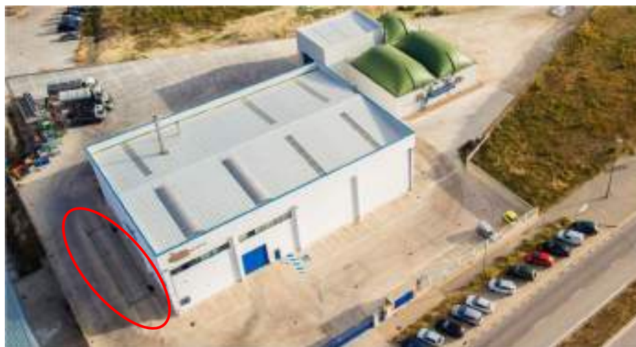
Ilustración 1. Ejemplo de báscula de medida a la entrada de una planta de gas renovable de AGF. Nave de descarga y Planta de biogás compacta.
