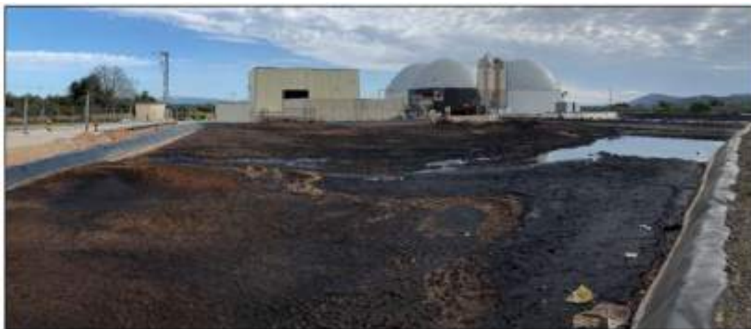
Ilustración 16. Ejemplo de balsa para almacenar alperujo.
