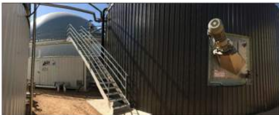
Ilustración 9. Planta de Biogás similar a la que se propone para este proyecto. Cúpulas, agitación, SE-2 y pasarela de tramex.
