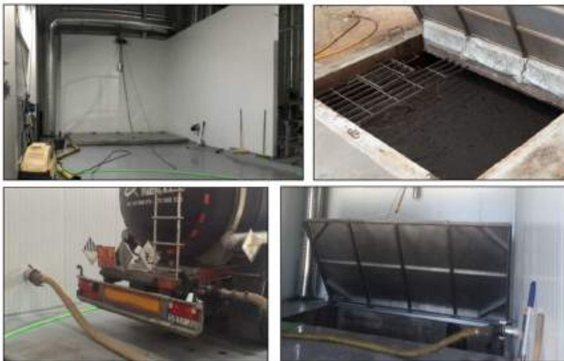
Ilustración 2. Zona de descarga en nave industrial de plantas AGF. Descarga directa o descarga por punto de conexión.
