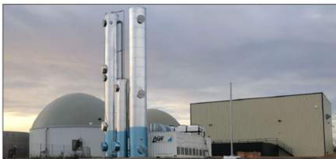
Ilustración 14. Planta de biometano comprimido. Tecnología AGF.
