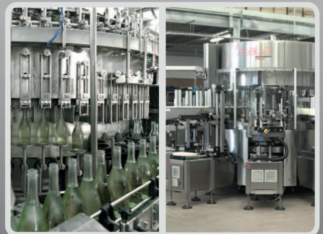
Sistema de llenado isobárico eléctro-neumático y nueva etiquetadora
